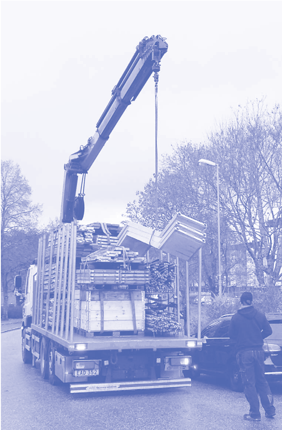
Här levereras byggnadsställning till fasadrenoveringen på Kruthornsvägen 15.
