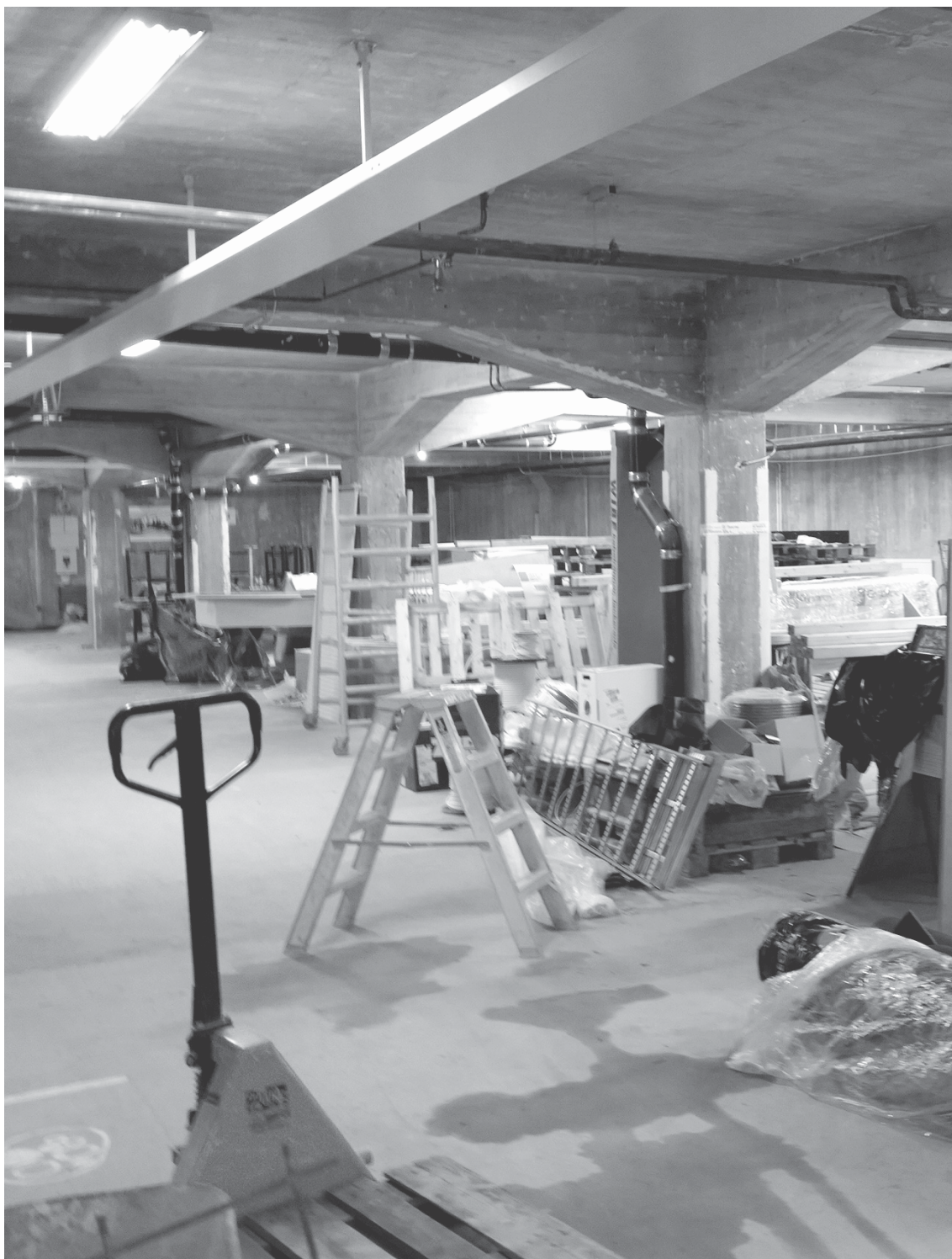
Den stora lokalen i källaren under affärshuset byggs om till föreningslokal.
