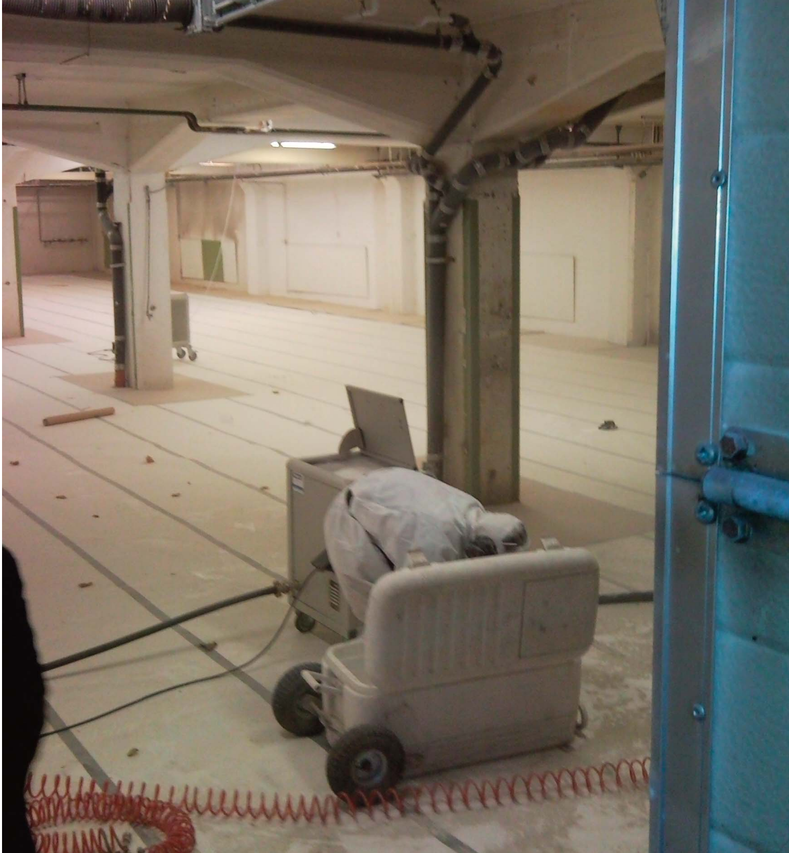
En bild från saneringen av den stora lokalen som sträcker sig under hela affärshuset. Nu finns här en föreningslokal så stor att den kan delas upp i tre eller fyra delar.
