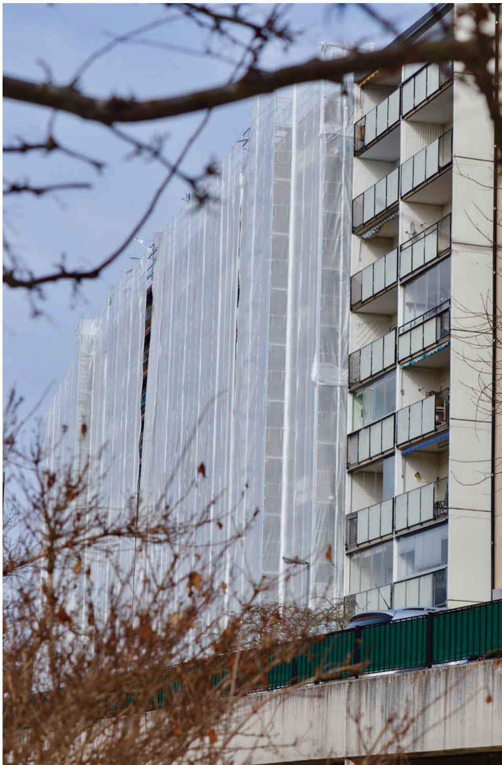
Fasadrenoveringen är det i särklass största underhållsprojektet i föreningens historia.
