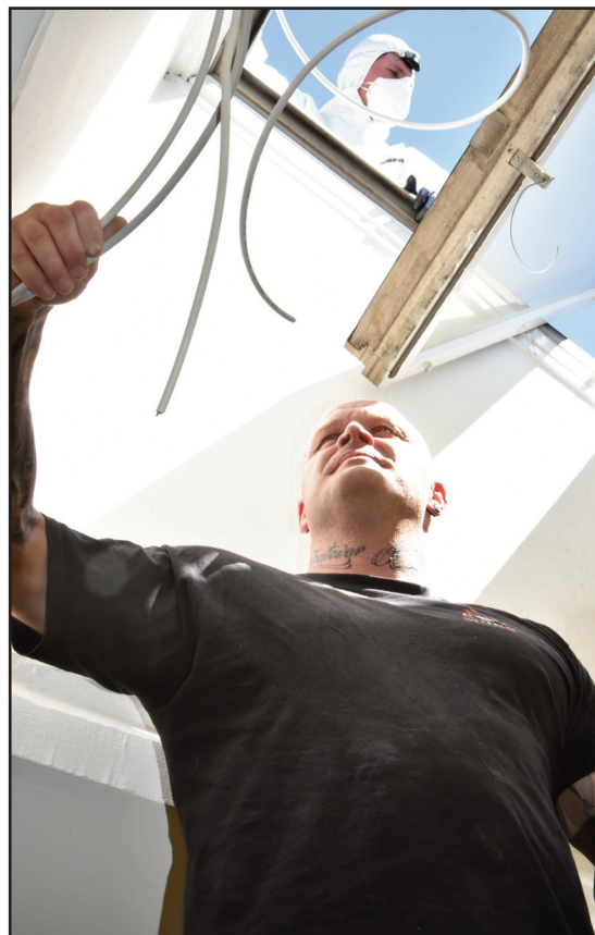
Här pågår arbetet med att byta en röklucka - till slut hade Ulf, Malte och deras kollegor bytt nästan femtio stycken.
