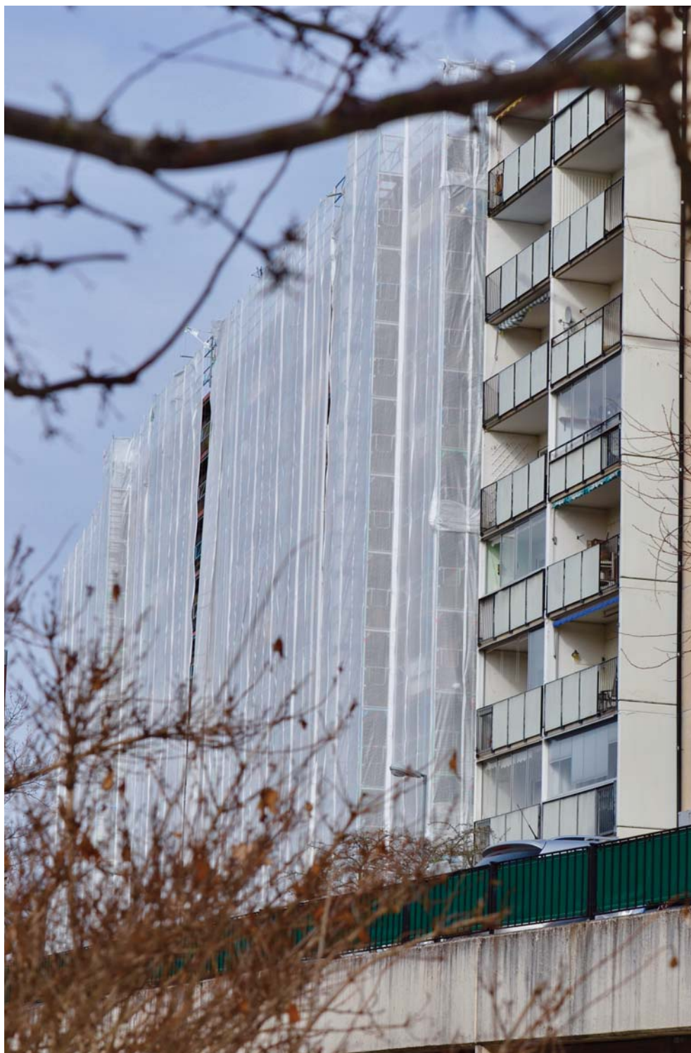
Fasadreoveringen är det i särklass största underhållsprojektet i föreningens historia.
